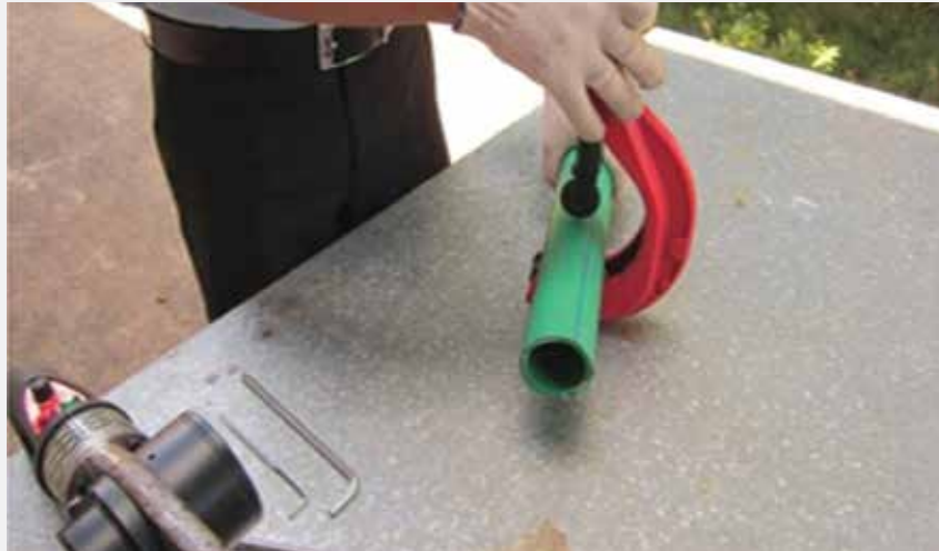
Cắt phẳng và lau sạch các mặt đầu ống cần nối. Trimming and cleaning the inner and outer surface of pipe and socket.
