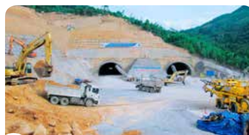
24 Hệ thống thoát nước Đèo Hải Vân, Đèo Cù Mông
