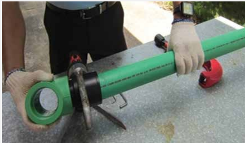
Gia nhiệt đều ống và khớp nối cần dán Heating the jointing surfaces of pipe and socket.
