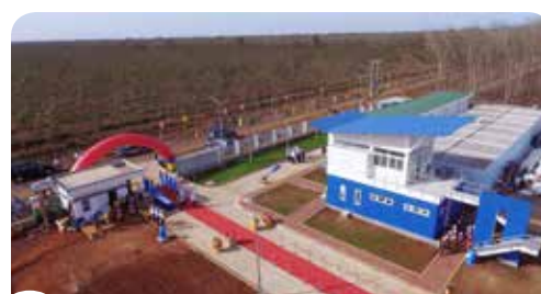
22 Nhà Máy Nước Chư Sê – Gia Lai
